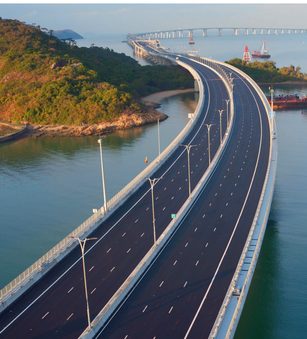
Pont Hong Kong-Zhuhai-Macao : Bouygues Travaux Publics, Dragages Hong Kong et VSL, filiales de Bouygues Construction, ont réalisé un tronçon de 9,4 kilomètres du plus long pont maritime mondial entre Hong Kong, Macao et Zhuhai.
